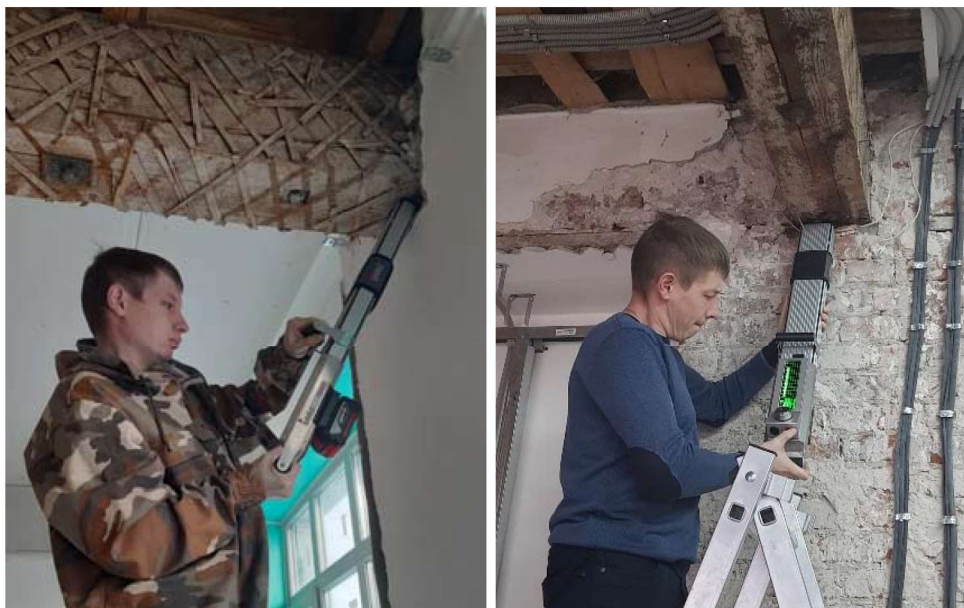
Рис. 2. Процесс измерения сопротивления сверлению мобильным устройством PowerDrill 400 при обследовании межэтажных балок перекрытий
