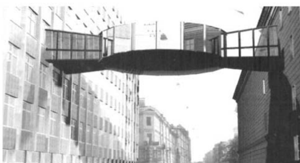
Рис. 12. Конструктивно-дизайнерское решение архитектурно-функционального пространства пешеходного перехода через ул. Егорова в Санкт-Петербурге на основе многогранной цилиндрической конструктивной системы (проф. В. Г. Темнов, инж.-архитекторы А. С. Рыбкин, А. С. Трапезников, дизайнеры Т. П. Банников, Ю. С. Пучкова)
