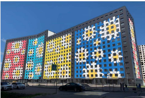
Рис. 1. Жилой комплекс «Ромашки» в Ленинградской области: материал фасада — окрашенная штукатурка по утеплителю (фото из архива авторов)
