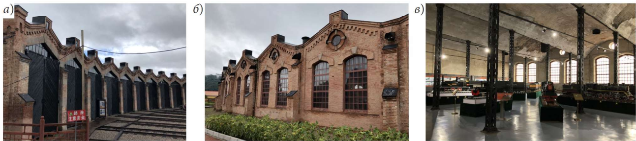
Рис. 9. Депо в Ханьдаохэцзы (фото автора), 2018 г: а — вид со стороны поворотного круга; б — задний фасад; в — интерьеры депо
