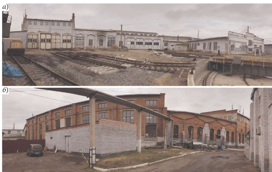
Рис. 7. Локомотивное депо в Уссурийске: а — вид со стороны поворотного круга; б — вид со стороны ул. Тупиковой на задний фасад (фото автора, 2022 г.)
