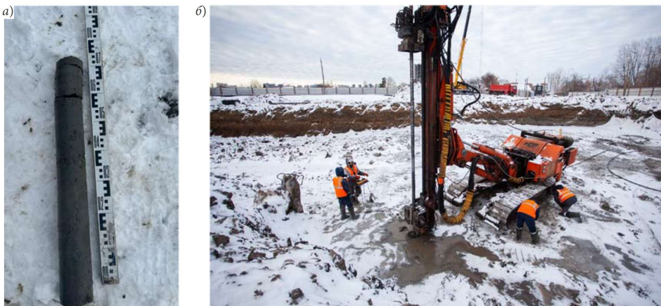
Рис. 6. Отбор кернов из оголовков грунтоцементных колонн: а — образец грунтоцемента; б — сбор образцов на строительной площадке
