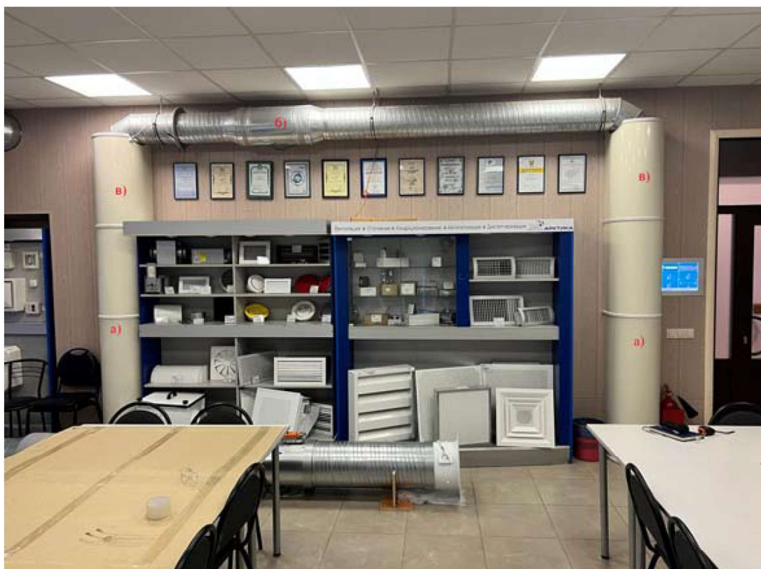
Рис. 1. Расположение элементов воздухораспределения: а — низкоскоростной воздухораспределитель; б — приточный воздуховод; в — декоративный кожух воздухораспределителя
