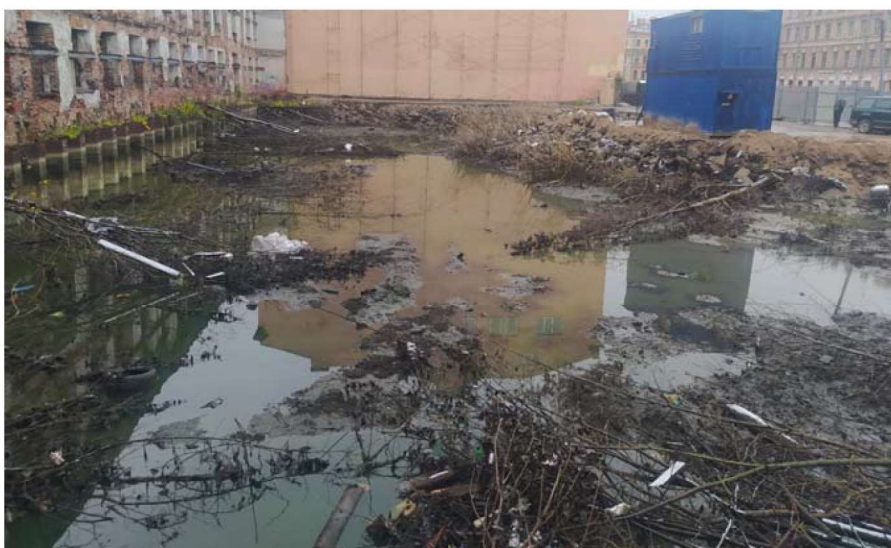
Рис. 1. Фото котлована, брошенного в 2008 г., состояние на октябрь 2022 г. (фото П. А. Кравченко)
