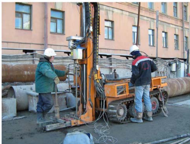
Рис. 2. Проведение работ по статическому зондированию
