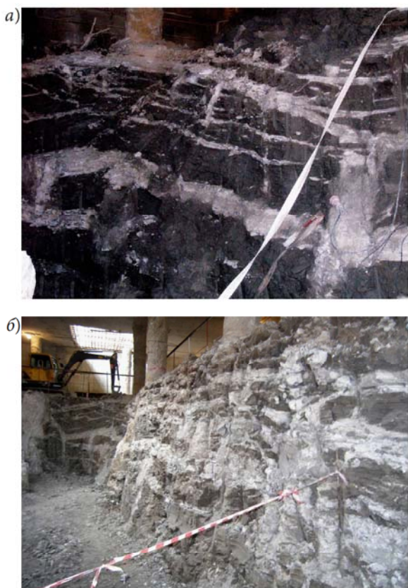
Рис. 7. Массив грунта, армированный полосками грунтоцемента при устройстве диафрагмы ниже дна котлована
