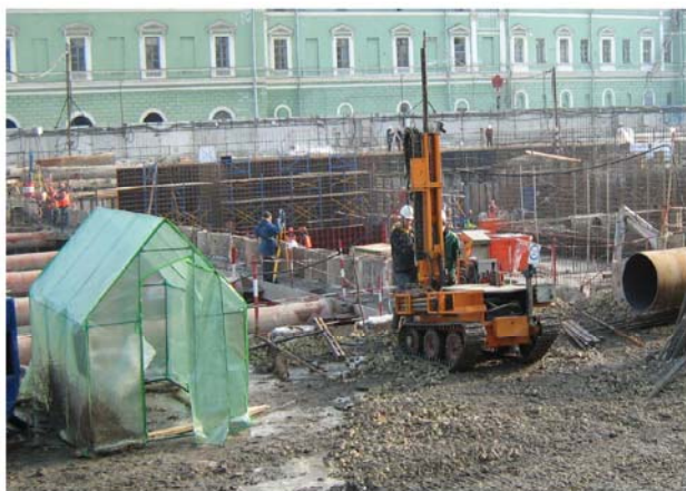
Рис. 1. Общий вид площадки и малогабаритной установки
