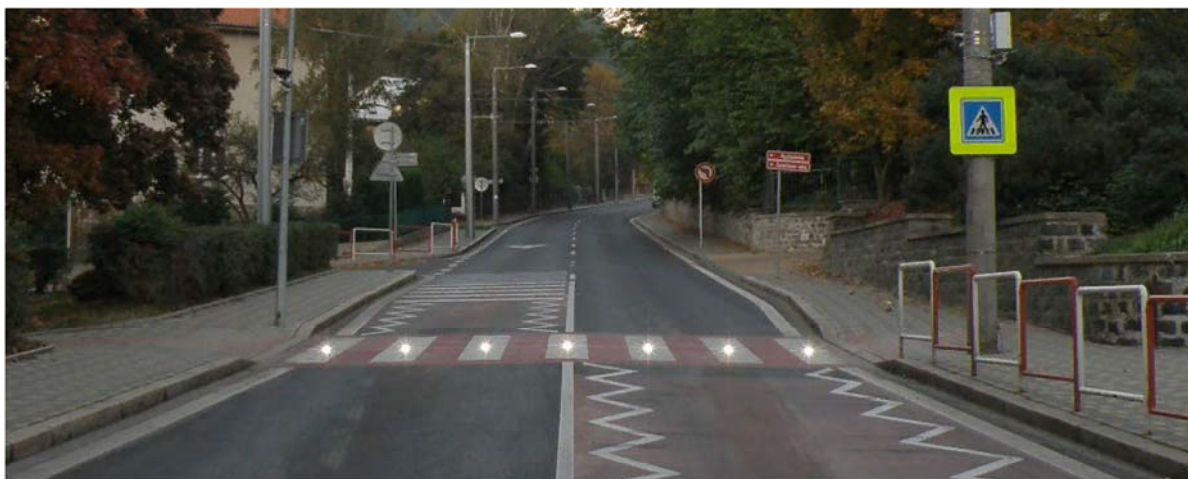
Рис. 6. Применение цветных покрытий в зоне пешеходного перехода
