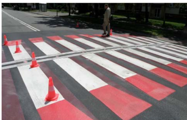
Рис. 10. Применение объемного изображения разметки 1.14
