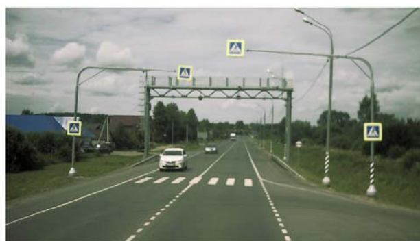
Рис. 2. Пример дублирования знаков 5.19.1. и 5.19.2 на Г-образных опорах
