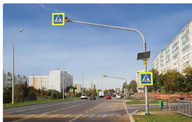
Рис. 3. Пример использования светофора «Т7» и дублирование знаков 5.19.1 на Г-образной опоре
