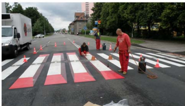
Рис. 9. Применение объемного изображения разметки 1.14
