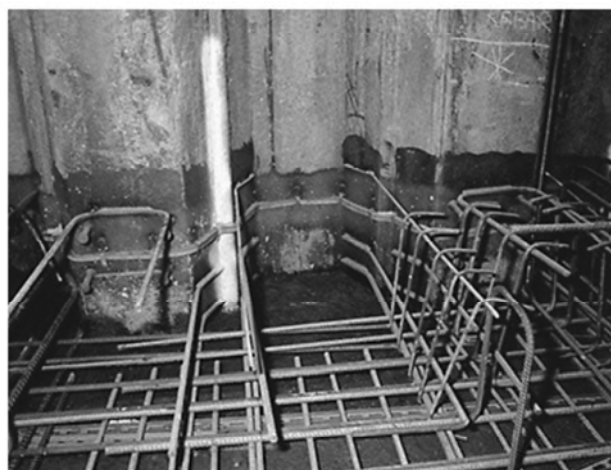
Рис. 9. Устройство соединения шпунтового ограждения с арматурными изделиями плиты основания ППТ [14]
