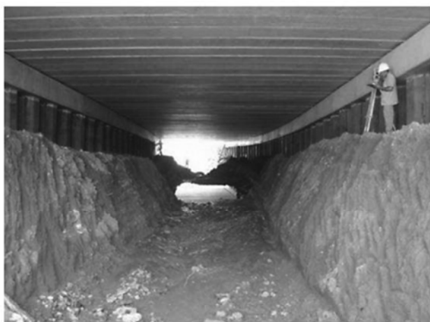
Рис. 8. Разработка грунта в тоннеле 5
