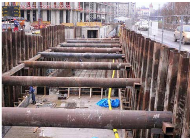
Рис. 2. Возведение ППТ открытым способом с применением стального шпунта в качестве ограждающих конструкций котлована и его креплением стальными балками 2
