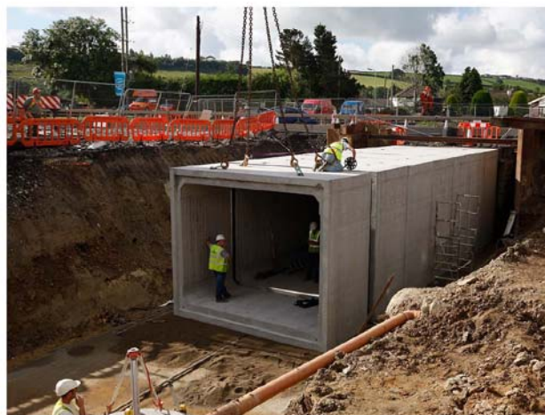
Рис. 3. Возведение ППТ из сборных железобетонных элементов 3
