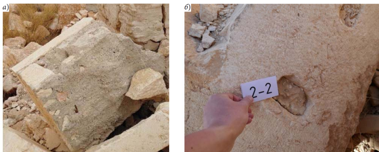
Рис. 7. Блоки, изготовленные с применением растворов и бетонов: а — блоки с бетонным «сердечником»; б — соединения «паз-шип»
