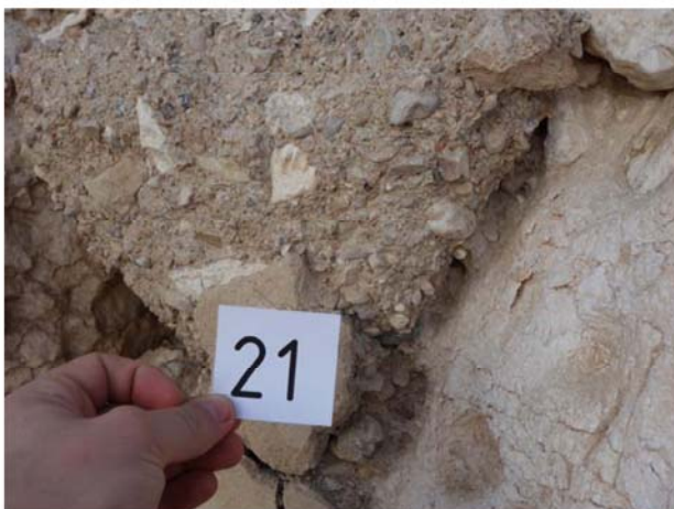
Рис. 8. Бетонный блок с пигментированной декоративной обмазкой
