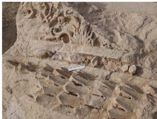
Рис. 10. Поврежденный при взрыве блок с резным декором
