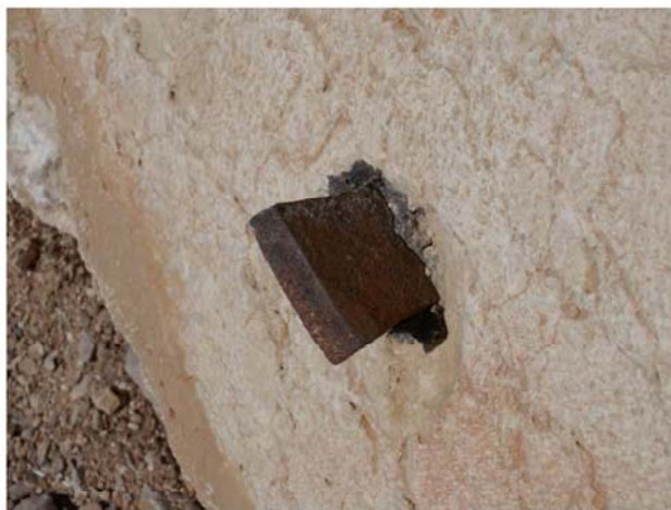
Рис. 9. Металлический «шип», зафиксированный свинцом
