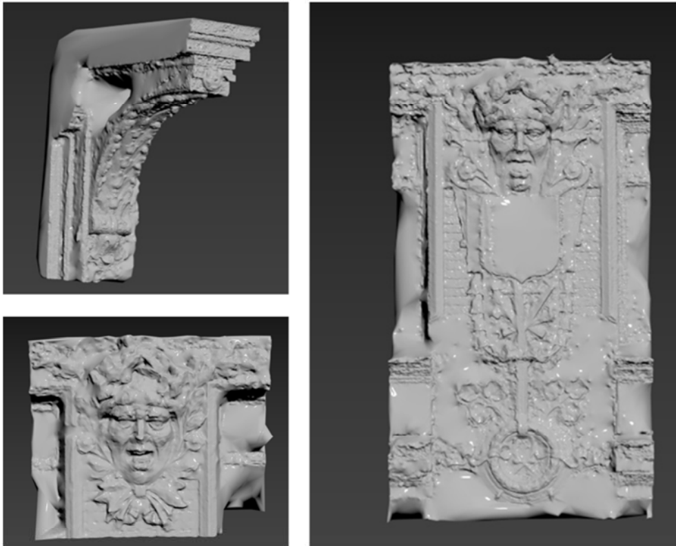
Рис. 4. Результаты лазерного сканирования декоративных частей фасадов здания
