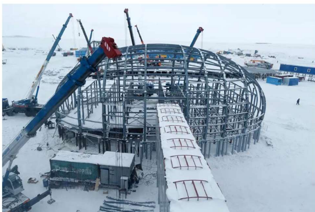
Рис. 1. Возведение каркаса из оцинкованных холодногнутых профилей одного из зданий комплекса «Арктический трилистник»
