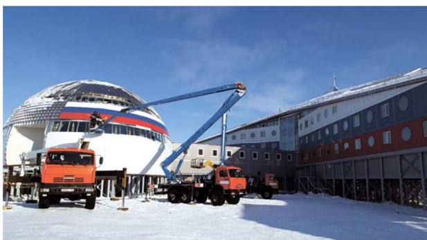
Рис. 2. Монтаж сэндвич-панелей одного из зданий комплекса «Арктический трилистник»
