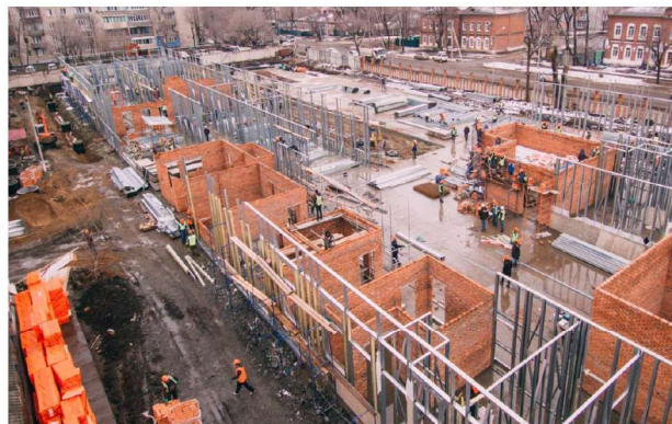
Рис. 3. Возведение каркасно-панельного здания [8] со встройками из кирпичных перегородок при строительстве многофункционального медицинского центра в г. Усурийске на 60 мест
