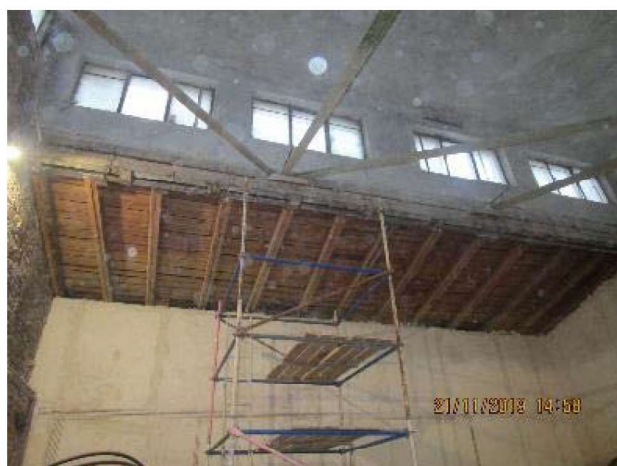
Рис. 1. Вид на перекрытие второго света
