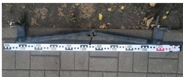
Рис. 3. Вид и размеры поврежденной части верхней поперечины
